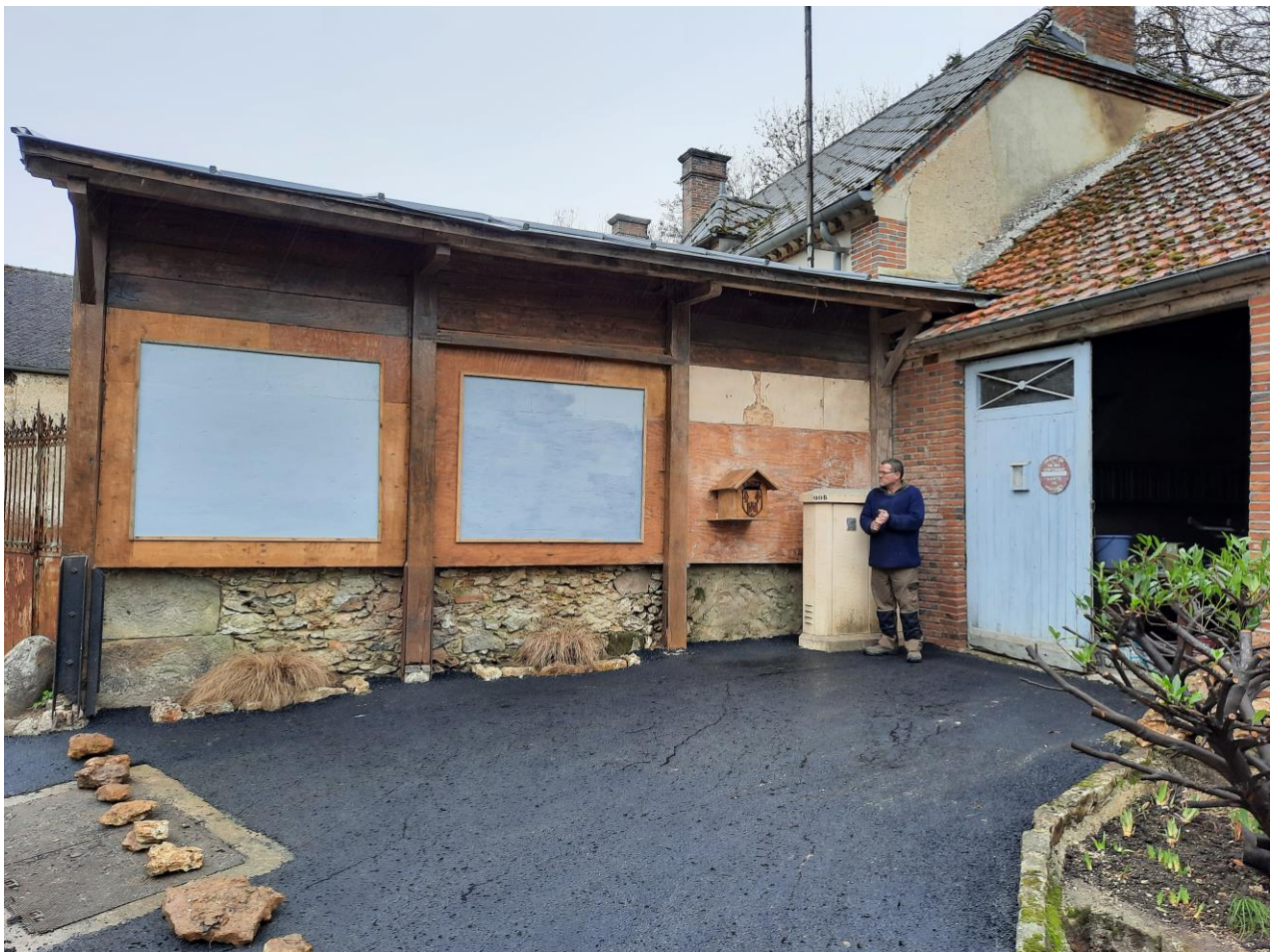
Photo : Entrée du local pompe
